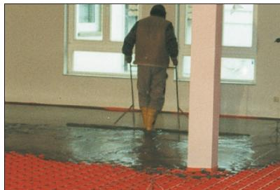
8. Einbau des Estrichmörtels ohne Bewehrung und ohne Bewegungsfugen.
