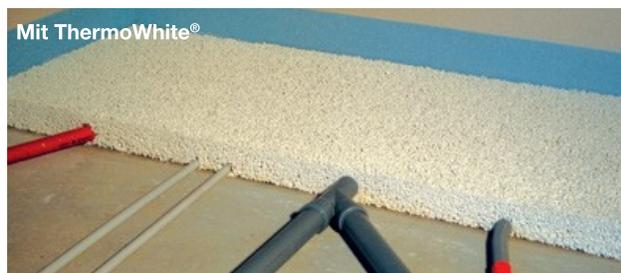
ThermoWhite® passt sich optimal an seine Umgebung an, Rohrleitungen werden formschlüssig ummantelt. Darüber hinaus sorgt ThermoWhite® für einen perfekten Niveaueausgleich, ist formstabil und hoch belastbar.
