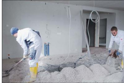
2. ThermoWhite® wird vor Ort gemischt und mittels Förderschlauch in das Haus gepumpt.
