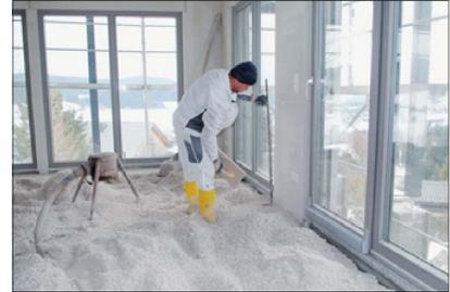
3. Die Wärmedämmung wird laut Meterriss auf das vorgesehene Niveau eingerichtet ...
