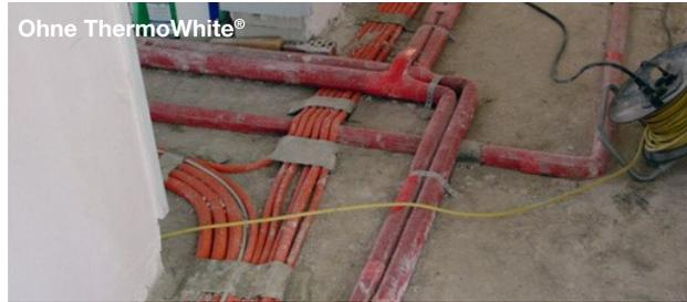
Vor einer großen Herausforderung stehen alle, wenn Installationen auf der Rohdecke montiert sind. Zahlreiche Rohre und Leitungen machen eine fachgerechte und schnelle Verlegung von Dämmplatten nahezu unmöglich. Durch das Zerschneiden der Platten entstehen Kälte- und Schallbrücken, die sich negativ auf die Wärmedämmung und die Raumakustik auswirken.
